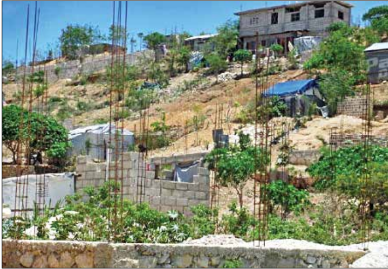
Le flanc typique de la colline de Canaan où de nombreuses maisons sont en chantier. Photo: AKJ/Milo Milfort
